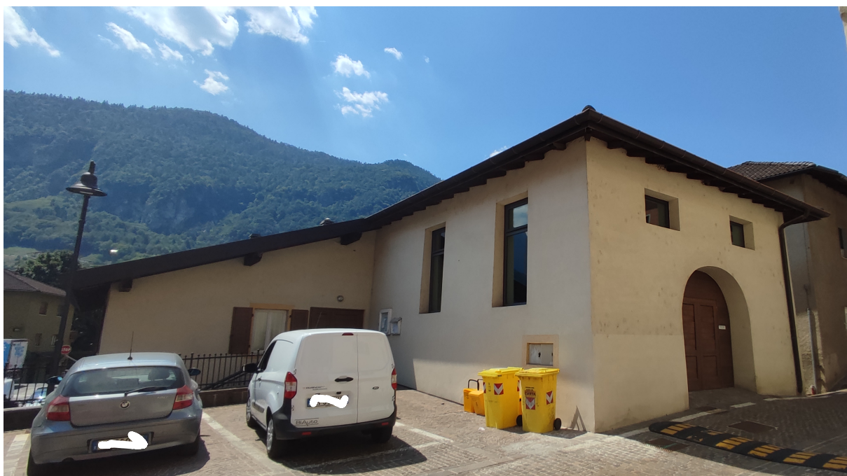
Foto 2: Edificio Palestra – Prospetto Nord-Ovest.
