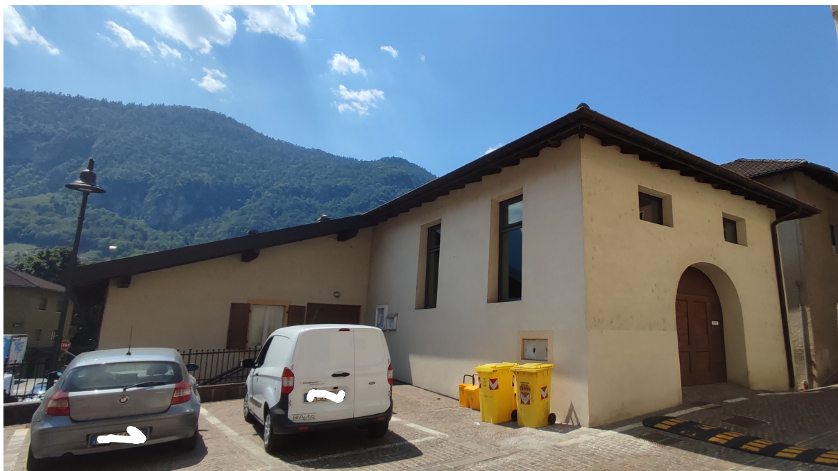
Foto 3: Edificio Palestra – Prospetto Nord-Ovest.
