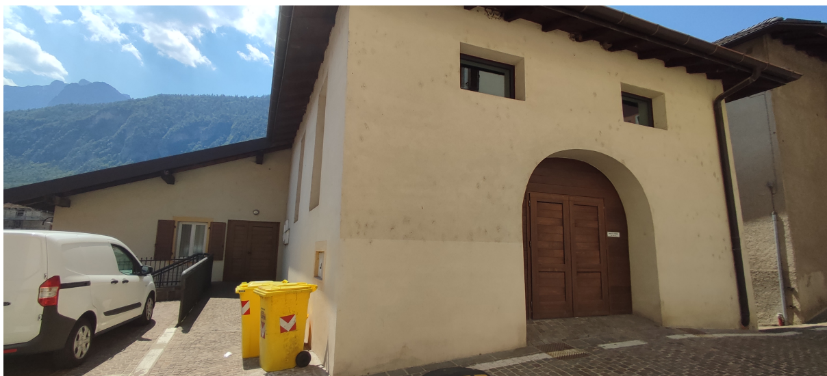
Foto 4: Edificio Palestra – Prospetto Nord.
