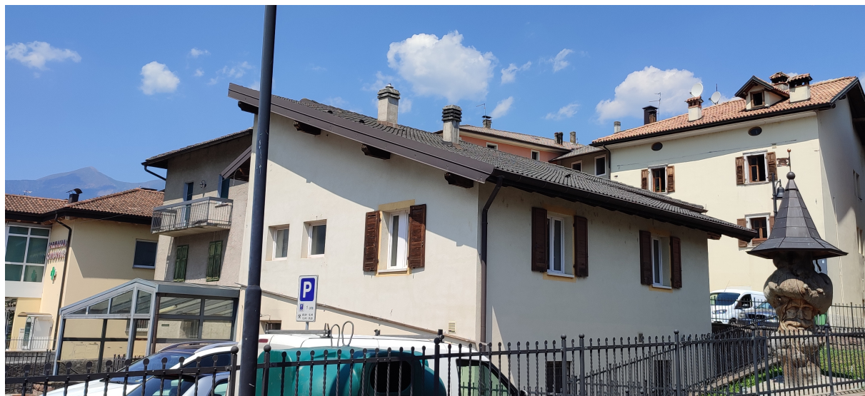
Foto 1: Edificio Palestra – Prospetto Sud-Est.
