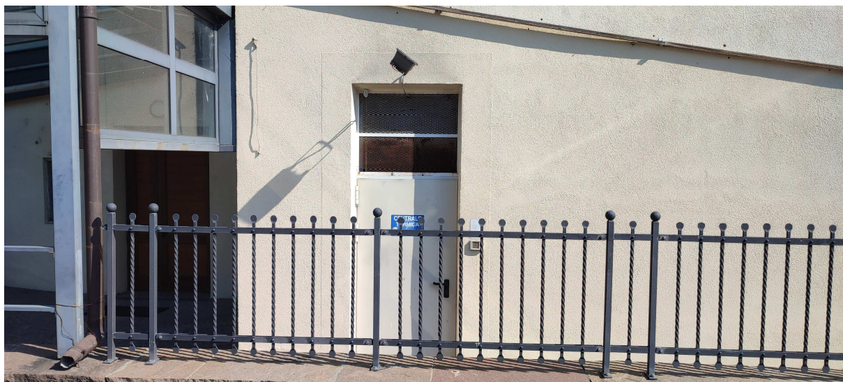
Foto 6: Particolare accesso esterno CT piano seminterrato.
