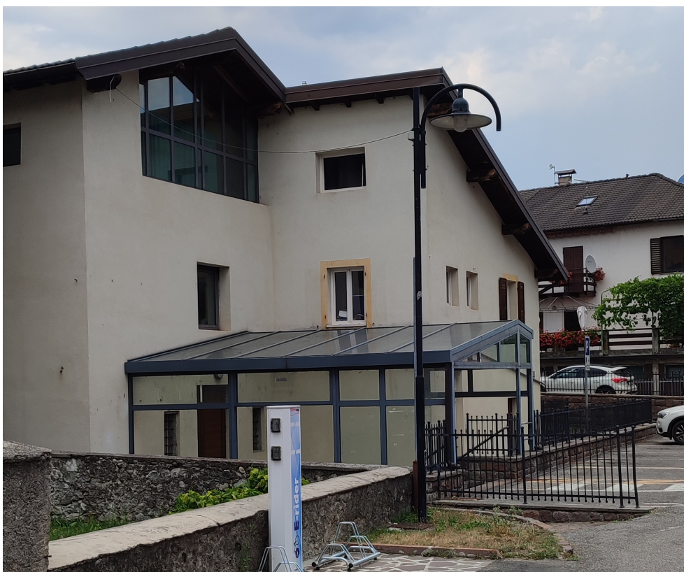
Foto 2: Edificio Palestra – Prospetto Sud-Ovest.
